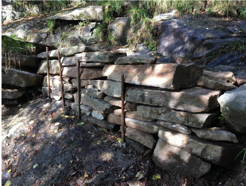
Figura 7: Elementi di sostegno in pietra per stabilizzazione sentiero
