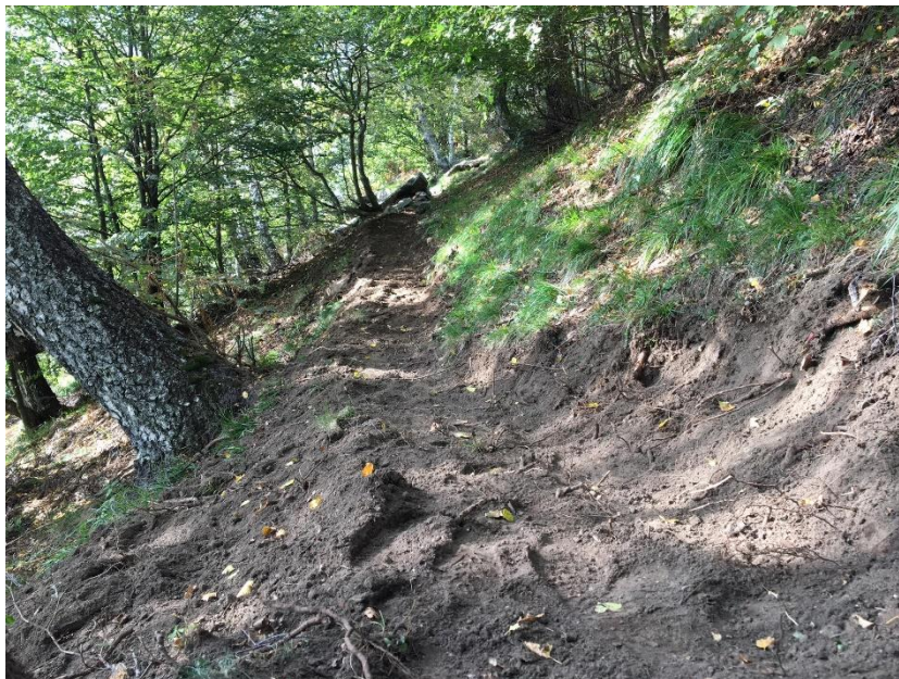
Figura 8: Ripristino e miglioria fondo sentiero a lavori ultimati.
