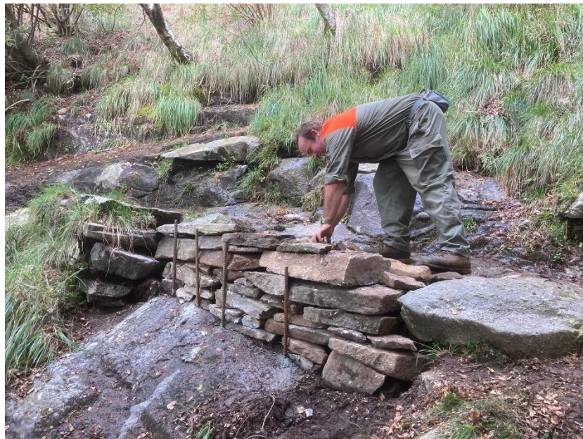
Figura 5: Creazione di elementi di sostegno in pietra per stabilizzazione sentiero
