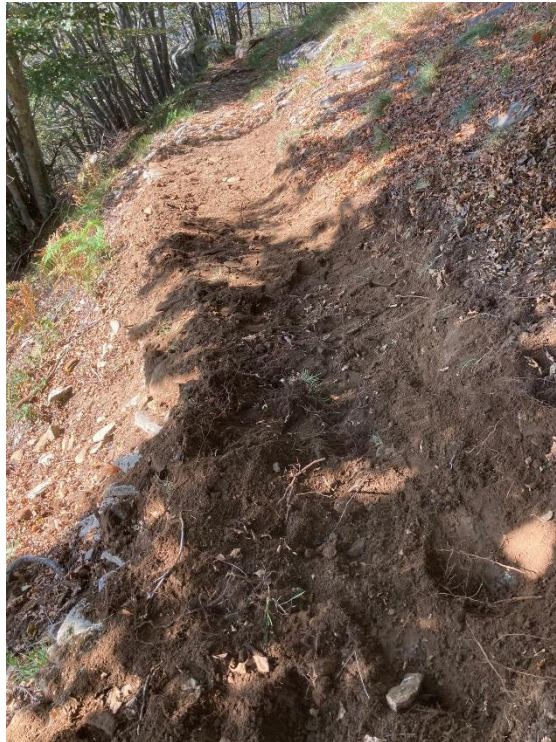
Figura 3: Inizio dei lavori di risanamento del fondo del sentiero
