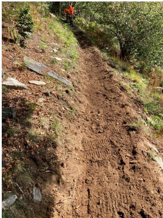
Figura 4: Proseguimento dei lavori di rifacimento del tratto interessato
