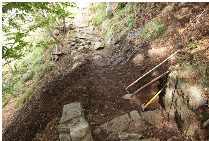
Figura 6: rimozione e riposizionamento pietrame lungo la zona di passaggio
